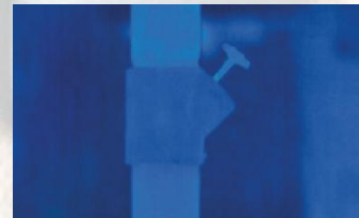
Ganzheitliche Dämmung Rohr und Ventil
